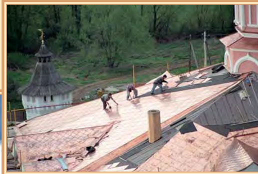
Работы на кровле Успенского собора
