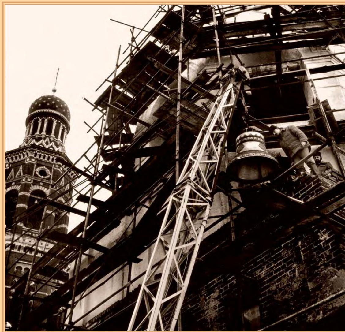
Ремонтно-восстановительные работы на малой шатровой колокольне
