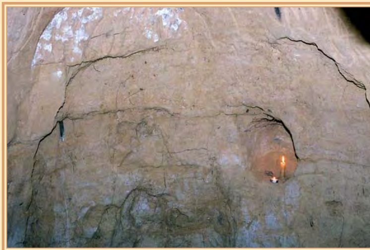
Ниша для светильников в восточной стене галереи, поднимающейся на второй, верхний ярус
